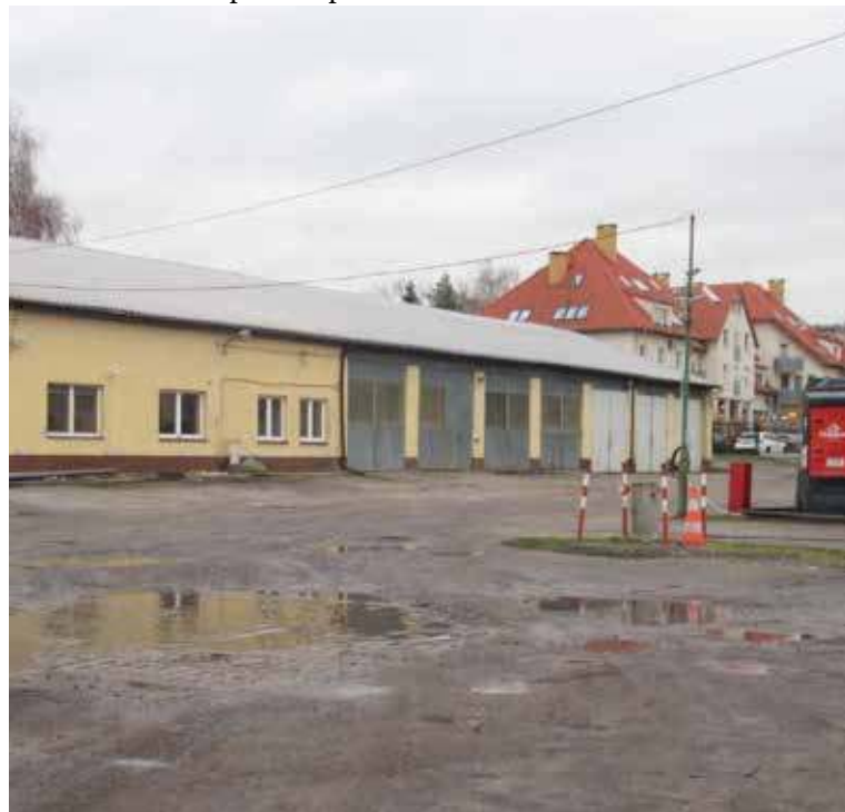
Na miejscu tego budynku ma powstać biurowiec kontenerowy oraz nowe garaże
