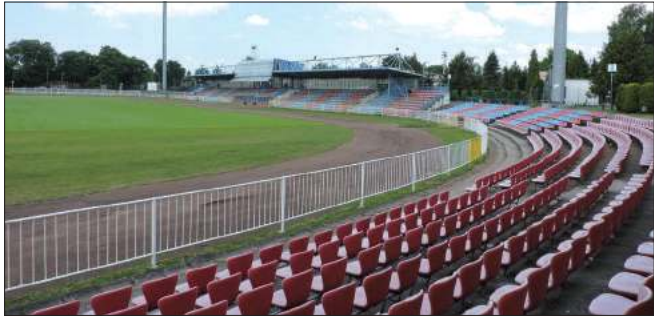
Stadion Aleja przy ul. Bogumińskiej w Wodzisławiu Śl. od lat aż prosi się o kapitalny remont
