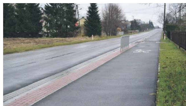
Jedną z inwestycji, które zaprezentowano wiceministrowi Weberowi była także ścieżka pieszo-rowerowa wzdłuż drogi wojewódzkiej w Jacie
