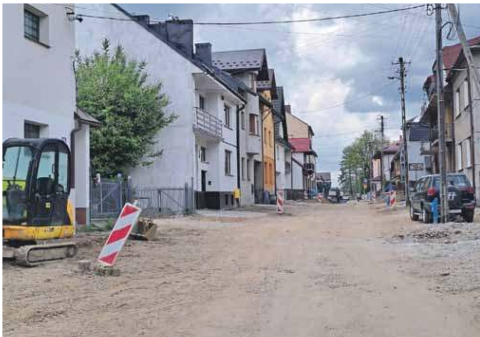
Głębokie wykopy w ul. Nadwodniej już zostały zasypane, przychodzi czas na wykonanie nowej nawierzchni.
