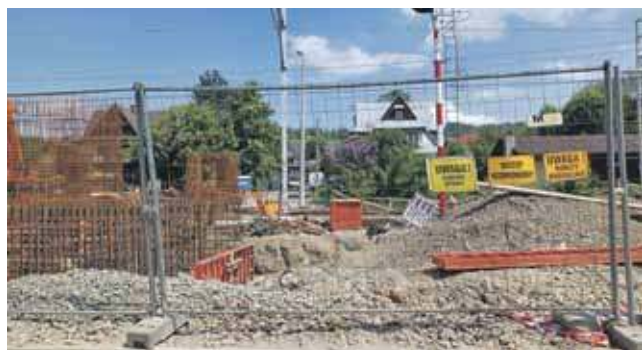
Budowa przejścia podziemnego pod torowiskiem przy stacji kolejowej PKP w Poroninie idzie pełną parą.
