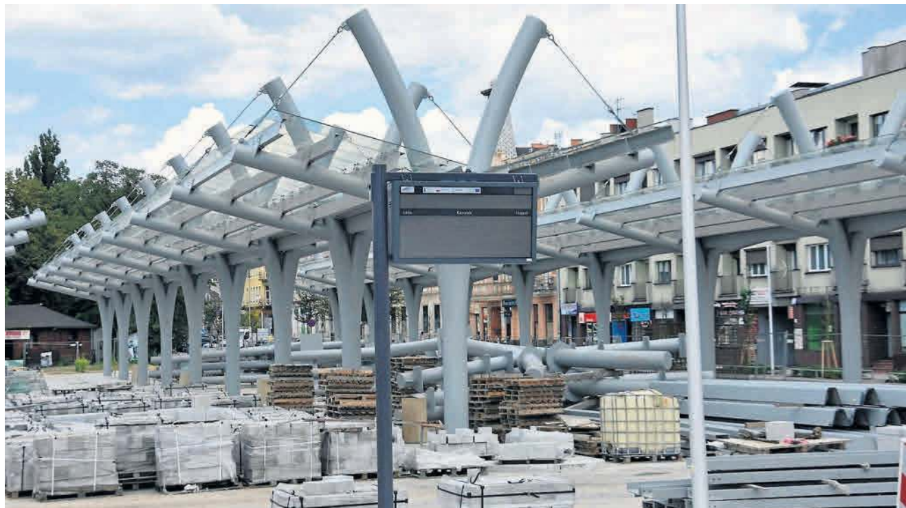
Trwają intensywne prace na placach budowy centrów przesiadkowych, które w Częstochowie powstaną przy dworcach Częstochowa Osobowa (na zdjęciu), Częstochowa Stradom oraz Częstochowa Raków. Według najnowszych informacji wkrótce poszczególne centra przesiadkowe powinny zostać oficjalnie odebrane i udostępnione dla pasażerów.
