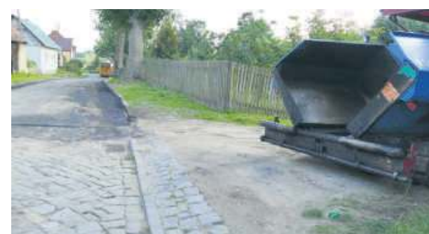
Remont drogi w Dzierzkowej polegał na położeniu masy bitumicznej
