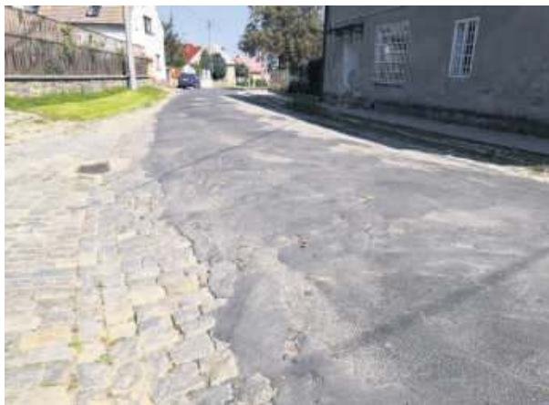
Powiat strzeliński liczy na dofinansowanie remontu kolejnego odcinka drogi w Gościęcicach
