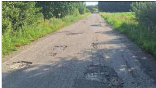
Prace prowadzone będą na odcinku 550 metrów długości nawierzchni jezdni
