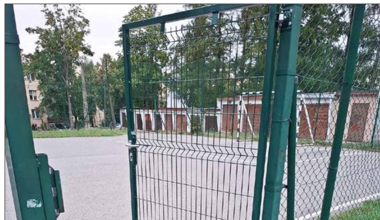
Furtka została odmalowana i naprawiona.
