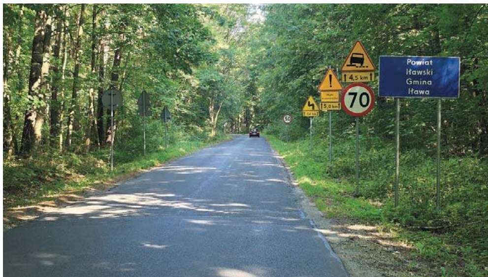
Lada chwila rozpocznie się kompleksowy remont drogi powiatowej od Iławy przez Katarzynki do Radomna
