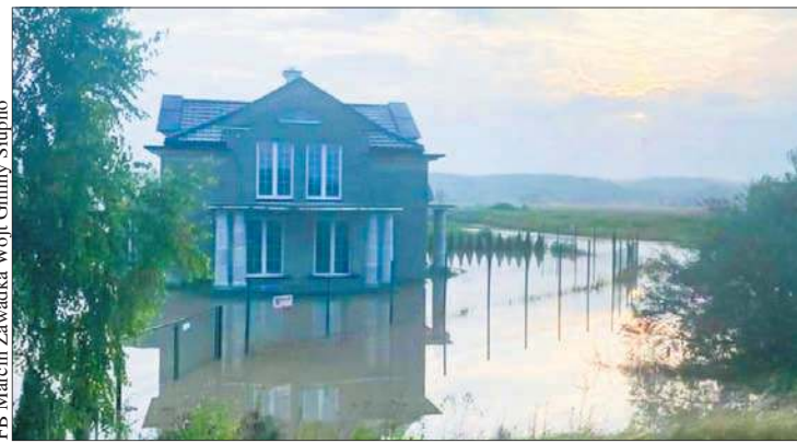
W gminie Słupno doszło do podtopień budynków mieszkalnych
