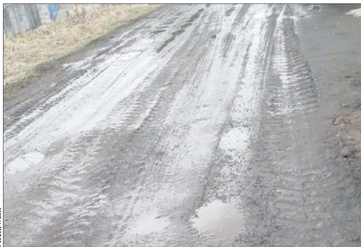
Osiedlowa droga w Woli Łąckiej
