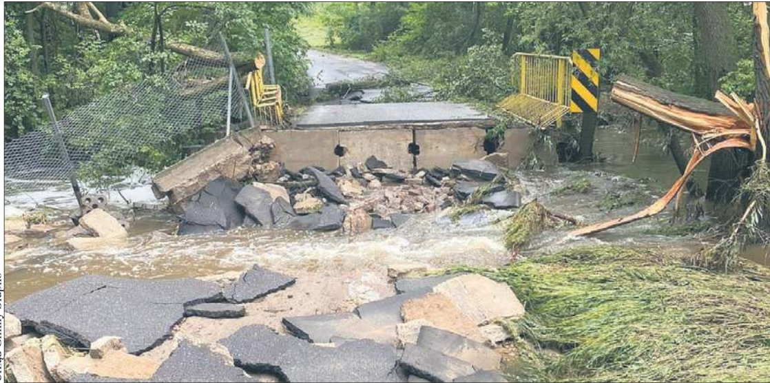
W gminie Słupno intensywne opady deszczu doprowadziły do wystąpienia z koryta Słupianki. Woda zniszczyła mosty i przepusty
