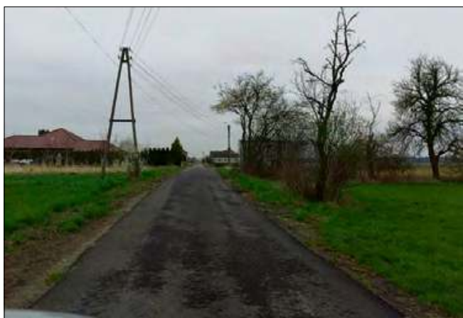
Remont ul. Leśnej w Zielinie. Zadanie kosztowało 54 871,36 zł.
