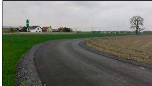
Remont ul. Ogrodowej w Łowkowicach. Wartość inwestycji to 50 871,36 zł.
