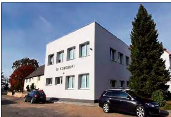
Przeprowadzono też kompleksową termomodernizację budynku Szkoły Podstawowej w Komornikach. To było najkosztowniejsze zadanie zrealizowane w 2021 roku.
