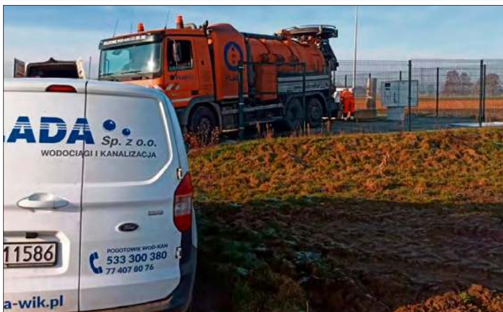
Plada przeprowadziła okresowy przegląd i serwis tłoczni ścieków w Luboszytach.
