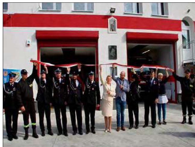
Kompleksowo odremontowano także remizę OSP w Strzeleczych.
