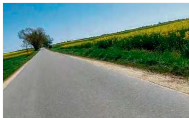
Przeprowadzono także konserwację poboczy dróg w Dziedzicach, Pisarzowicach i Strzeleczych. Wartość zadania to 103 300 zł.
