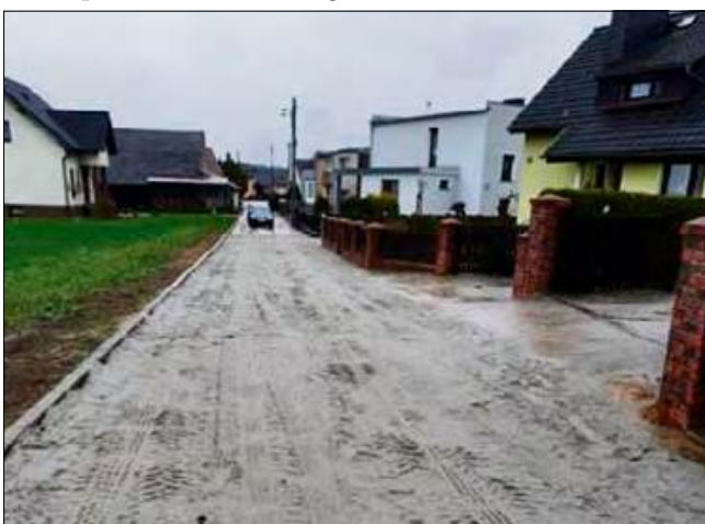
A to już rozbudowa odcinka sieci wodociągowej i kanalizacyjnej w Dobrej. Zadanie kosztowało 203 407,81 zł.
