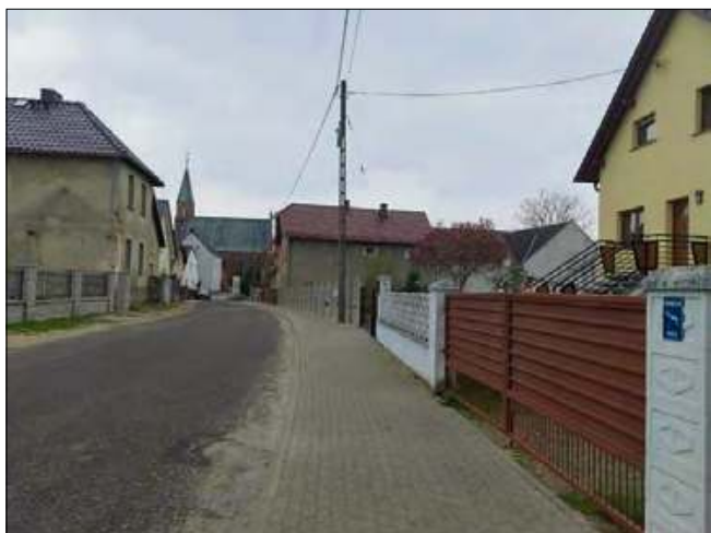
Remont części chodnika na ul. Kościelnej w Komornikach. Wartość zadania - 22 121,71 zł.
