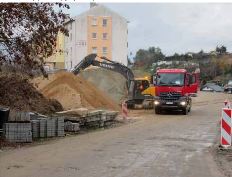
Praca na budowie wre.
