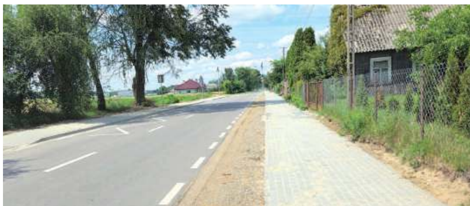
Ponad kilometrowy odcinek drogi dla pieszych powstał dzięki otrzymanemu dofinansowaniu oraz współpracy gminy Kąkolewnica i powiatu radzyńskiego
