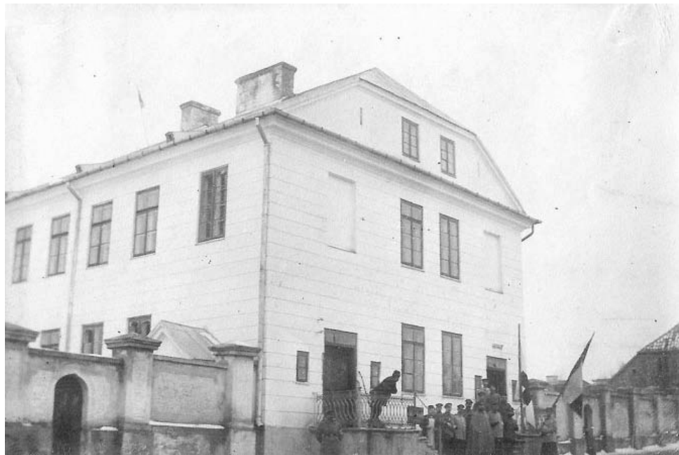
Budynek szpitala znajdował się przy ulicy Niborskiej 21
