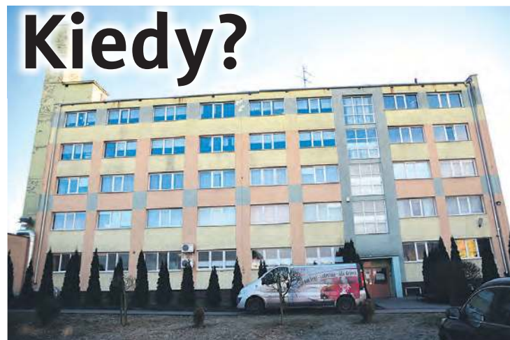
W przyszłym roku rusza rozbudowa Zakładu Aktywności Zawodowej.
