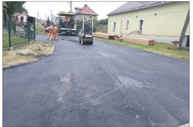
Prace na drodze w Biedrzychowicach
