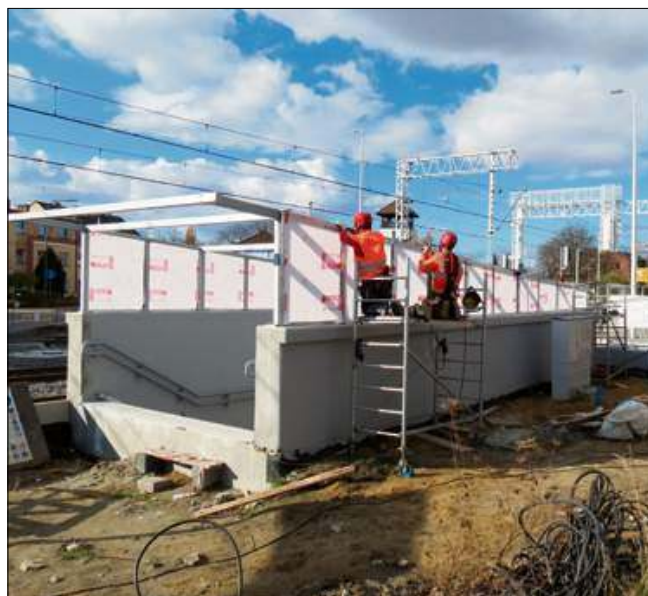
Trwają już prace wykończeniowe.
