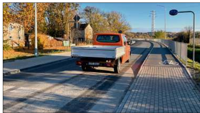
Jezdnia na moście jest wąska i nie ma linii oddzielającej kierunki ruchu.
