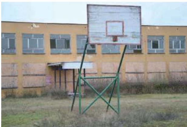
Przed szkołą teren zarosnięty chaszczami. Za budynkiem - opuszczone boisko sportowe. Szkoła w Górcie zakończyła bowiem funkcjonowanie wiele lat temu
