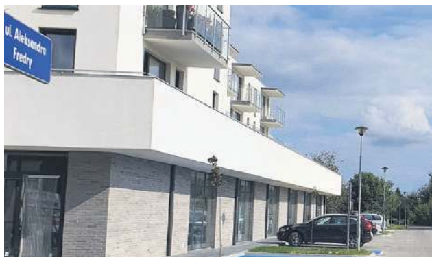
Nowe bloki powstają m.in. przy ul. Lipskiej.
