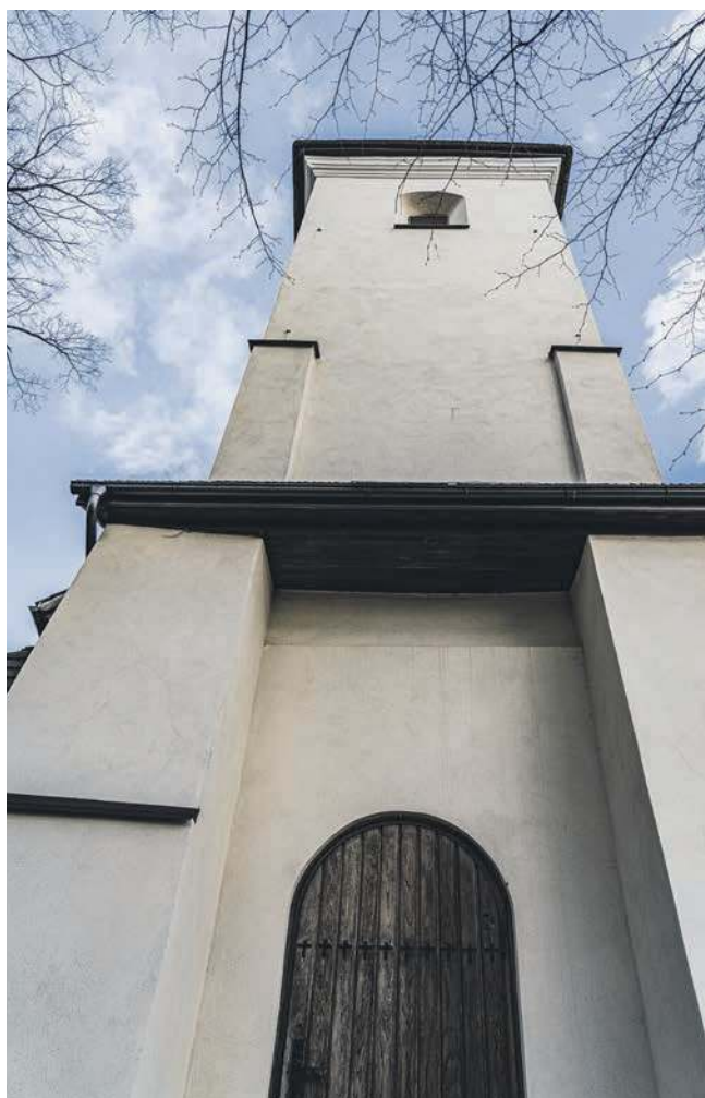
Frontowa ściana kościoła
