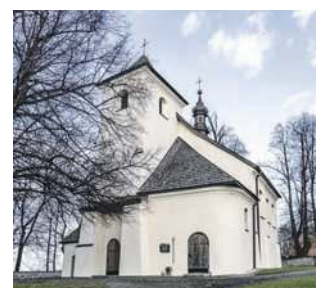
Widok od strony głównego wejścia
