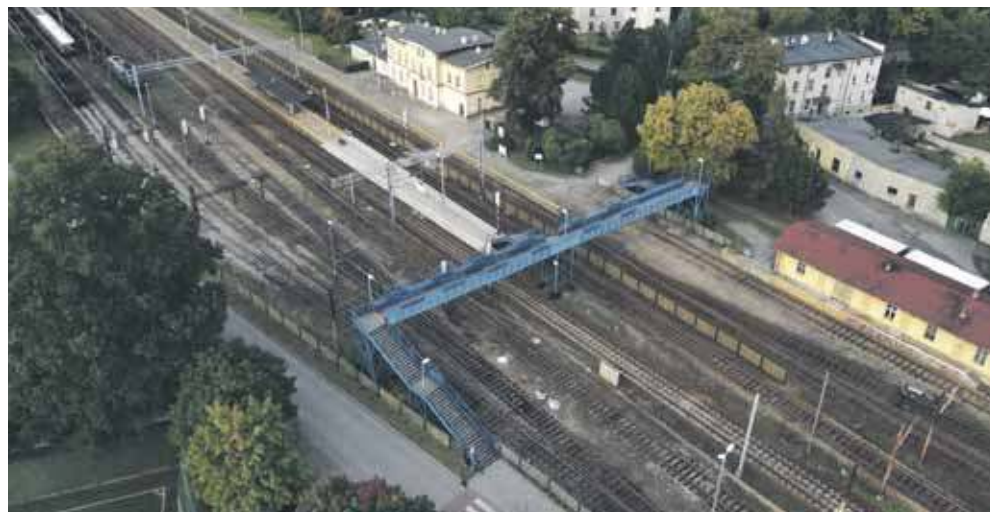
Kładka na dworcu kolejowym w Kaletach jest zmorą dla rowerzystów i osób z wózkami. Żeby dostać się na peron, z którego odjeżdżają pociągi, trzeba pokonać kilkadziesiąt stopni w górę, a potem w dół
