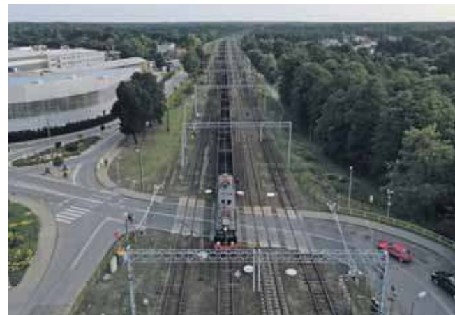
Przejazd w centrum Kalet ma zostać zastąpiony wiaduktem lub tunelem
