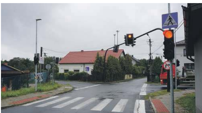
Na skrzyżowaniu ul. Zwycięstwa, Leśnej i Szczakowskiej w Trzebinii wybudowano przejścia dla pieszych, sygnalizację świetlną i wyremontowano chodniki
