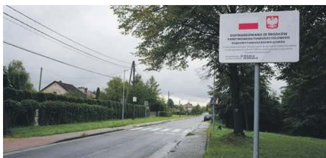
Doświetlono przejście dla pieszych na ul. Styczniowej w Luszowicach (w rejonie skrzyżowania z ul. Luszowicką). Tradycyjne znaki drogowe wymieniono na znaki aktywne, zamontowano lustro sferyczne, wprowadzono ograniczenie prędkości do 40 km/godz. Nawierzchnię oznaczono fakturowo
