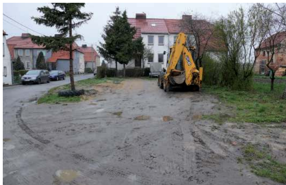
W ramach środków z funduszu sołectwa, w Wyszonowicach zostanie wykonany parking dla mieszkańców tzw. Kaoliny na działce widocznej na zdjęciu
