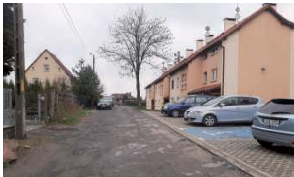
Oprócz budowy oświetlenia na ul. F. Chopina w Strzelinie, zostanie także wyremontowana droga
