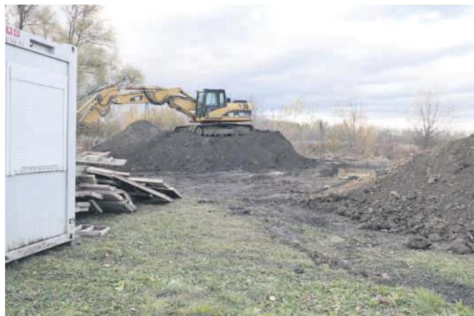
W ubiegłym tygodniu wykonano pierwsze prace budowlane – zebrano humus z miejsca, gdzie ma stanąć budynek
