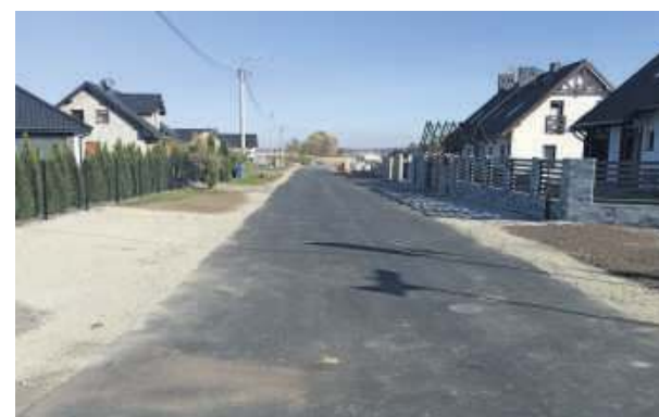
Tak wygląda ul. Dębowa w Borku Strzeleńskim po przebudowie. Foto. UG Borów
