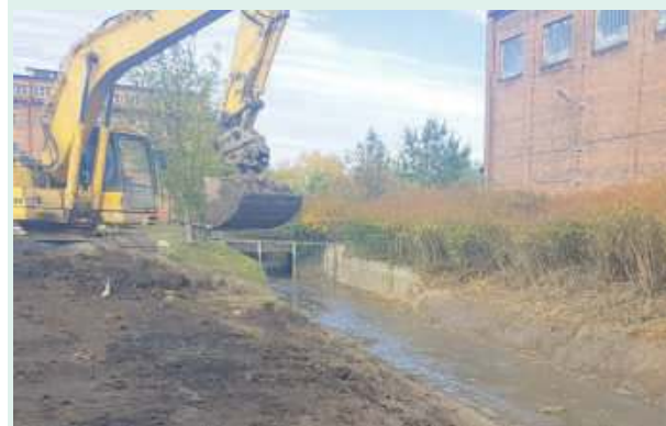
Koryto Oławki na wysokości Ziębic przechodzi gruntowny remont
