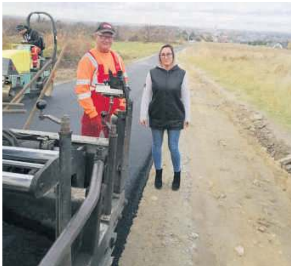
Na zdjęciu radna z Gęsińca Agnieszka Ruszek, która jako jedna z kilku o tę inwestycję od dawna zabiegała. Obok pracownik firmy w trakcie kładzenia asfaltu
