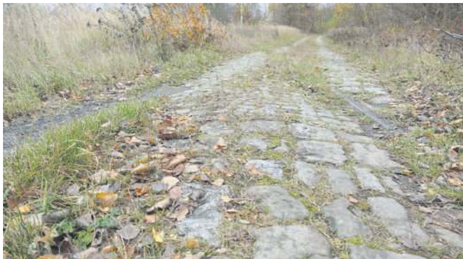
W ramach „Dolnośląskiej Cyklostrady” zaplanowano budowę ścieżek rowerowych biegnących po nasypach nieczynnych linii kolejowych. W Kaszówce (na zdjęciu) nie ma już prawie śladu po torach, zachował się jedynie ich fragment przy rampie...
