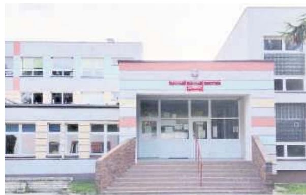
Część remontów w ZSP Borów, zaplanowanych na wakacje, wykonano w trakcie roku szkolnego, kiedy dzieci uczyły się zdalnie.
