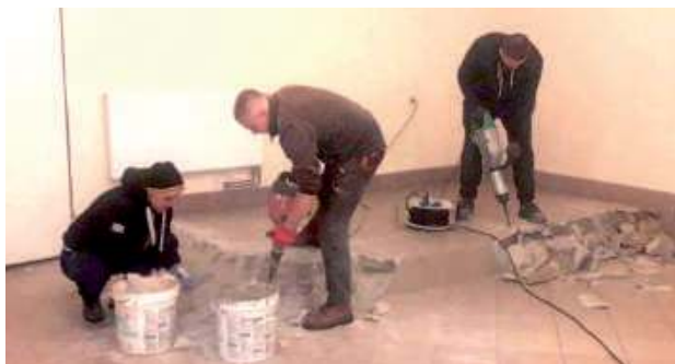
Prace remontowe rozpoczęły się w styczniu
