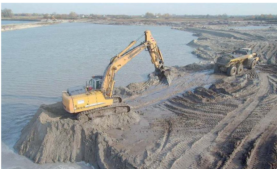
Prace nad zbiornikiem retencyjnym zakończą się pod koniec 2019 roku
