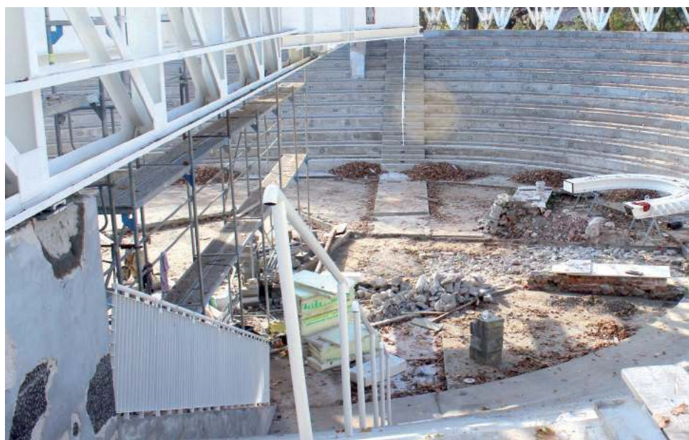
Na wiele miesięcy budowa zamarła. Trwało oczekiwanie na przeprojektowanie i opracowanie dokumentacji technicznej, aby wzmocnić konstrukcję zadaszania
