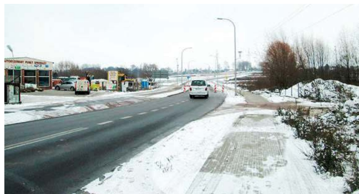
Wjazd na nowy odcinek od strony ul. Płockiej
