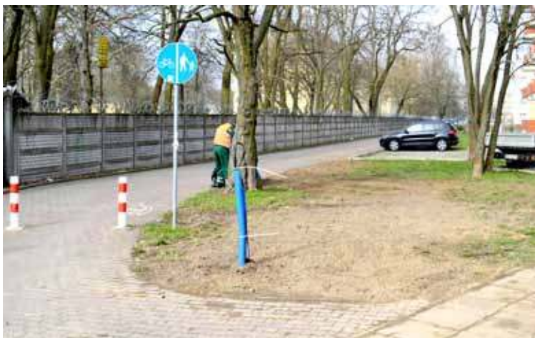
Trwa montaż latarni wzdłuż ciągu pieszo-rowerowego łączącego ul. Pogodną z al. Żołnierza
