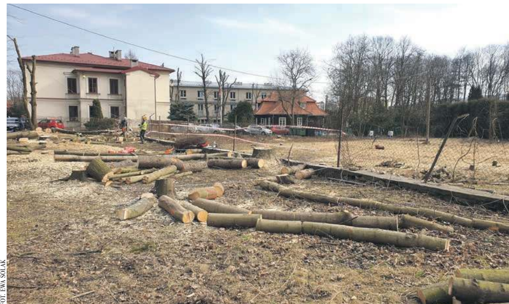
Prace przygotowawcze pod budowę sali gimnastycznej przy LO w Krzeszowicach
