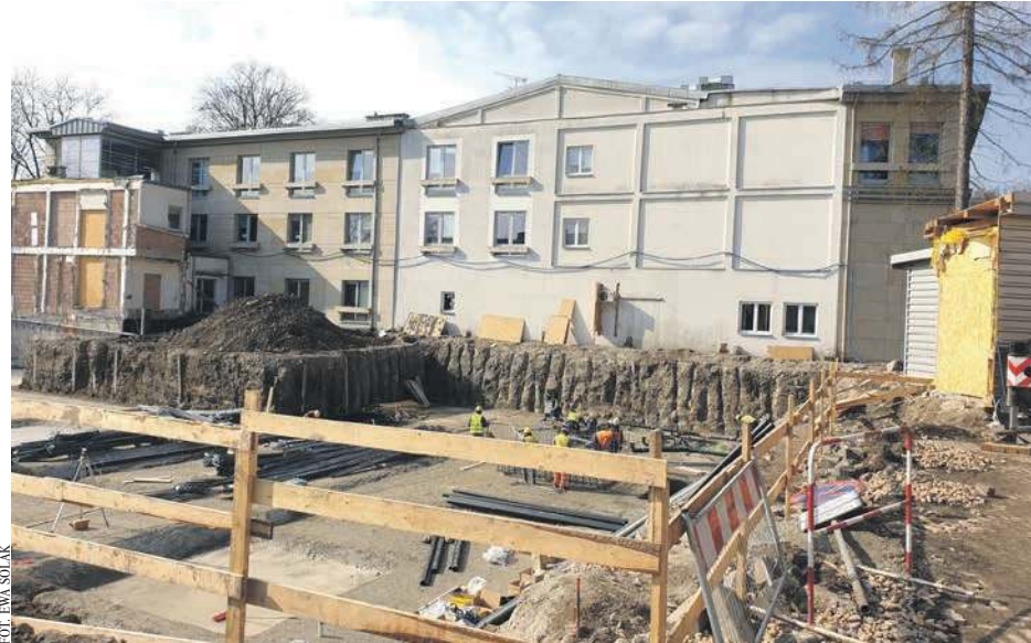
(E) Prace w balneologii, widoczne od strony Daszyńskiego w Krzeszowicach
