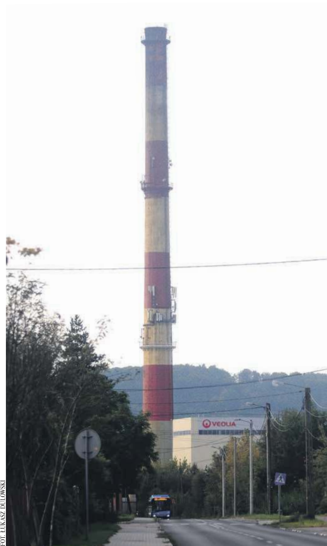
Ciepłownia spółki Veolia Południe przy Pogorskiej w Chrzanowie
