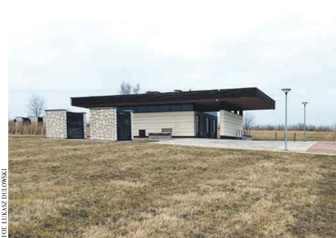
... istniejącego budynku z toaletami
