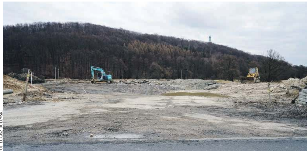
Prace ziemne są prowadzone przy ul. Prusa w Alwerni
