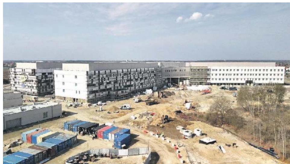
Budowa Nowego Szpitala Onkologicznego idzie pełną parą
