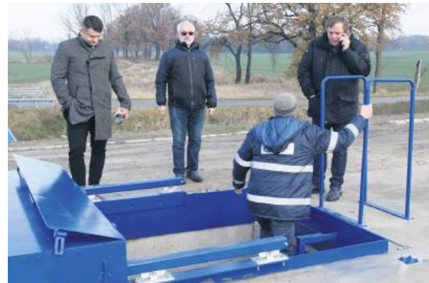
Odbiór techniczny wieży zrzutowej zbiornika zalewowego w Przewornie odbył się 9 grudnia br.
