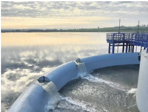
Wyremontowana wieża zrzutowa
