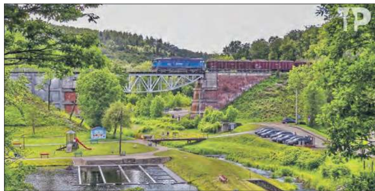
Czy most kolejowy między Moszczanką a Pokrzywną nadal będzie granicą gmin i powiatów?
