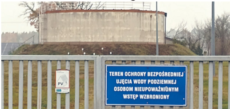
Ujęcie wody pitnej w Czeplinie
