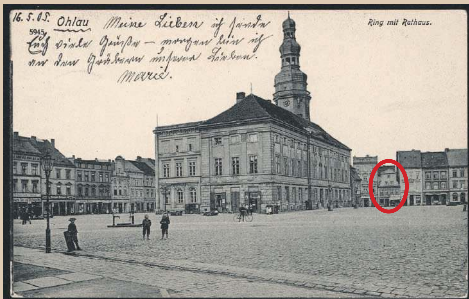
Przedwojenna pocztówka, zaznaczono kamienicę, w której był sklep rodziny Gruschka. Fotografie wykonano stojąc tyłem do obecnego Sanktuarium NMP Matki Pocieszenia
