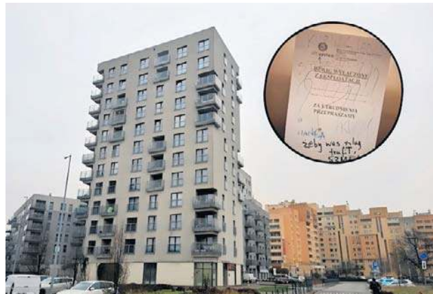
Kartka z informacją o awarii zawieszona na windzie wywołała wściekłość. Pojawiły się na niej wyzwiska, a klatka (do 5. piętra) została „ozdobiona” rysunkami i napisami
