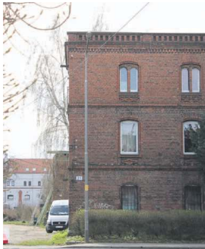
Budynek dawnej wytwórni cygar przy dzisiejszej ul. Janowskiego 21
