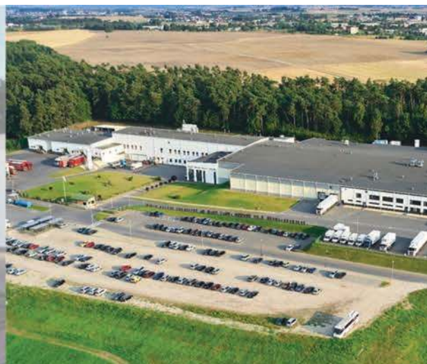
Ubojnia Trzody Chlewnej w Chojnicach.
