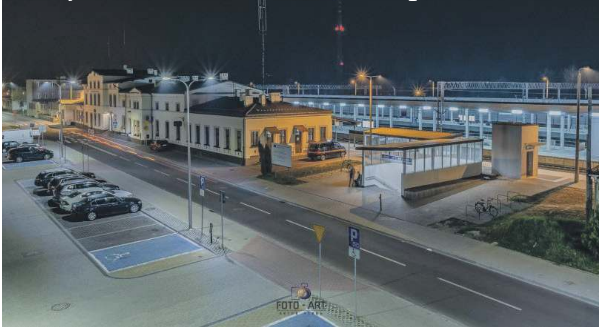
Obiekty dworca w Trzebini 2024 r. widziane od strony wiaduktu. Zdjęcie Artur Sarna (PRZEŁOMowe Kadry)
