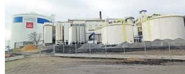
Strzelińska cukrownia zatrudnia ponad 100 osób
