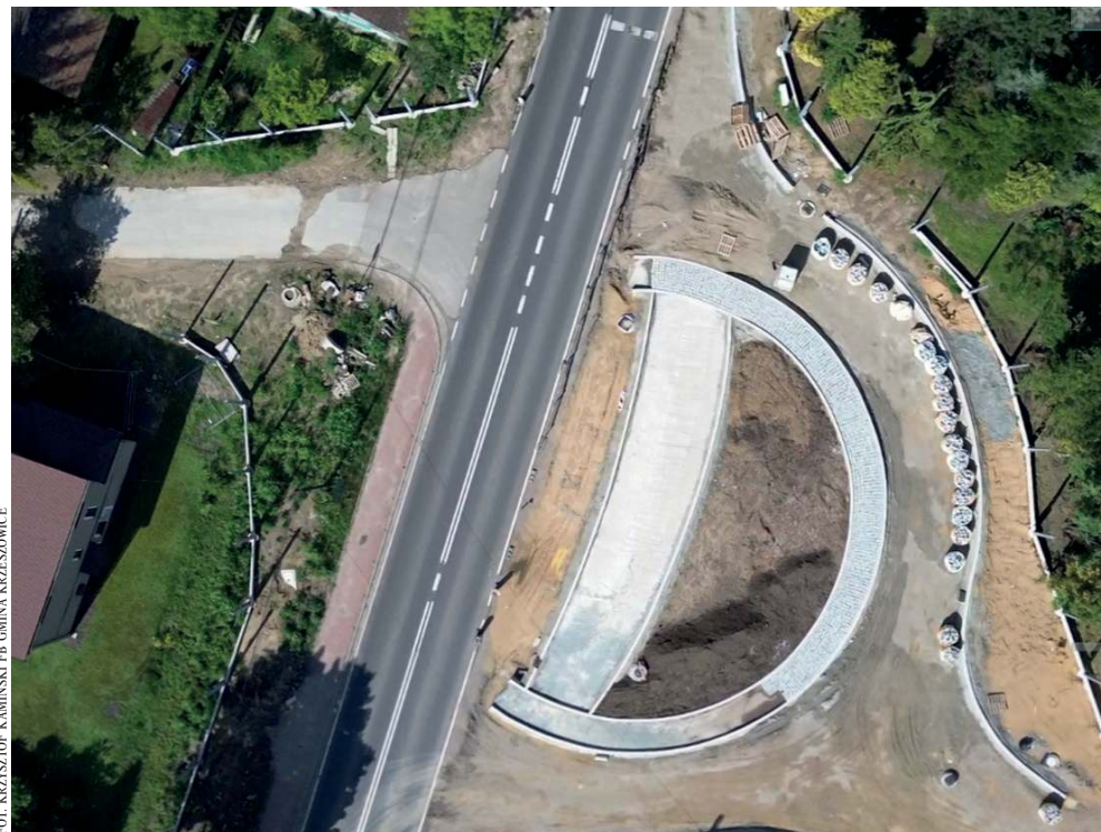
Rondo powstające na krajówce w Krzeszowicach
