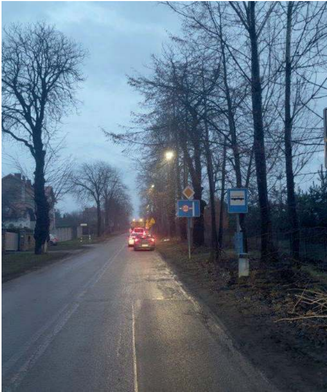
Nowa lokalizacja przystanków przy Sobieskiego w Plazie
