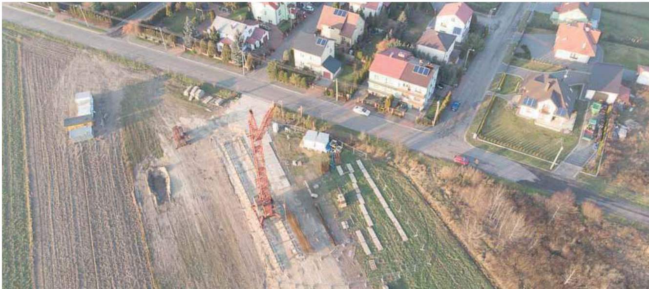
Ruszyła budowa bloku mieszkalnego przy ulicy Włodawskiej
