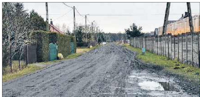
Obecnie ulica Zadworna to droga gruntowa, na jej stan skarżyli się mieszkańcy
