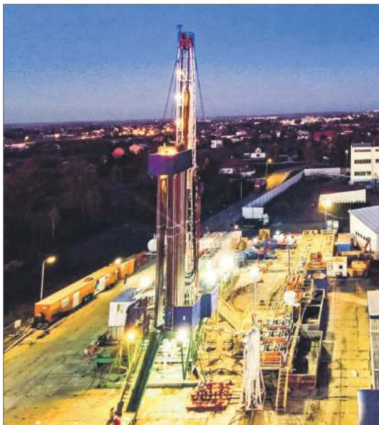
W Dębicy odwiert geotermalny wykonywała firma Exalo Drilling.
