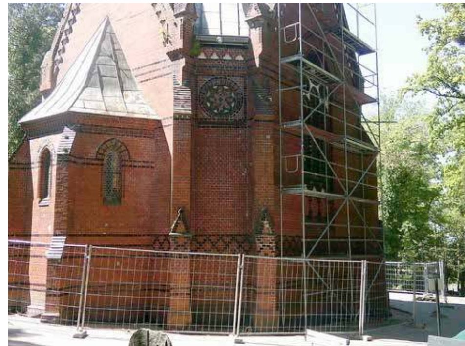
Kaplica w remoncie
