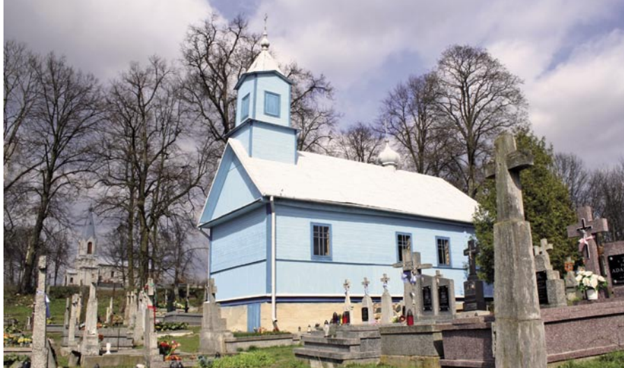
Pochodząca z końca XVIII w. cerkiew cmentarna Opieki Matki Bożej w Mielniku (2007 r.), wzniesiona zapewne w miejscu, gdzie wcześniej stała cerkiew parafialna Narodzenia Bogurodzicy, możliwe że za władania książąt ruskich murowana – na „ostrej górze, na placu dawnym, gdzie cerkiew murowana była” (opis z 1726 r.).
