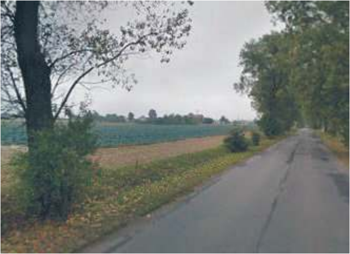
Odcinek ulicy Pasiecznej na terenie Lublina nie jest oświetlony – przy tej samej ulicy w granicach gminy Konopnica od dawna stoją latarnie
