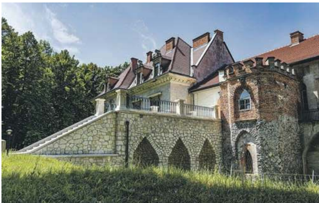
Częściowo odnowiona tylna strona pałacu
