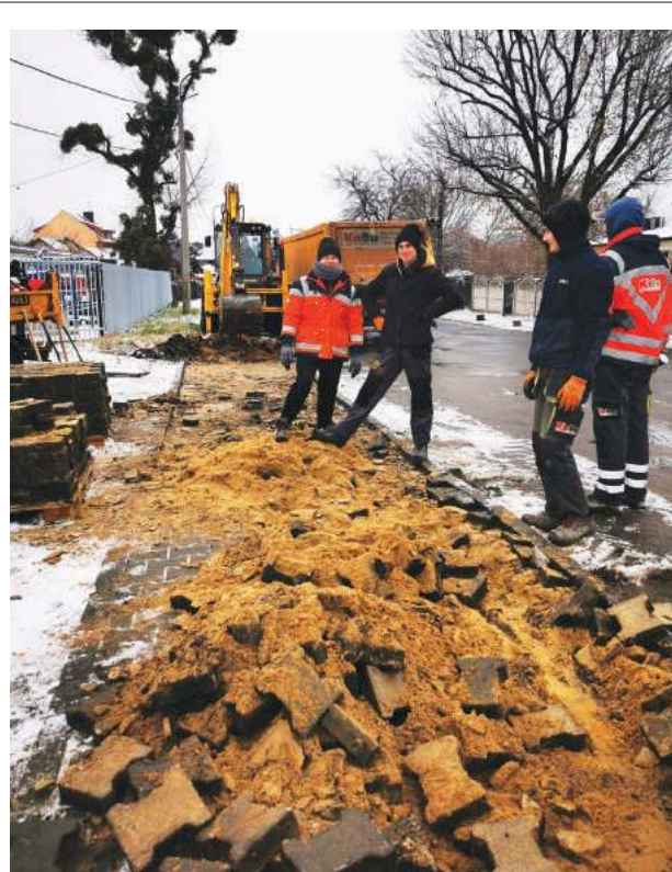
Remont chodnika właśnie się rozpoczął
