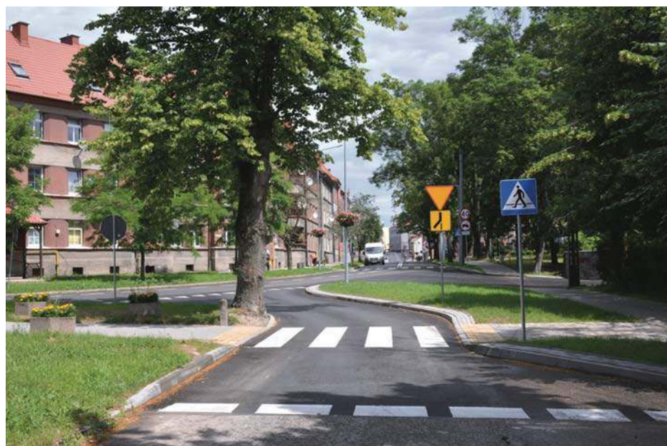
Przebudowana ulica Kolejowa w Olecku
